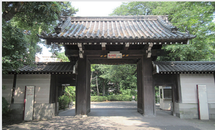
現在も大学の正門として利用されている「正門」
