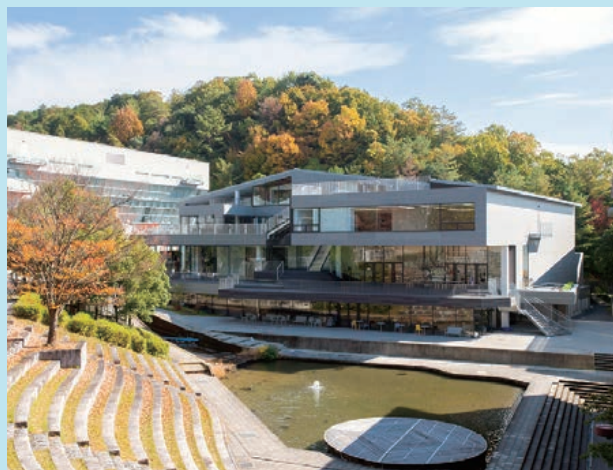
2022年2月に新設した「明窓館」
