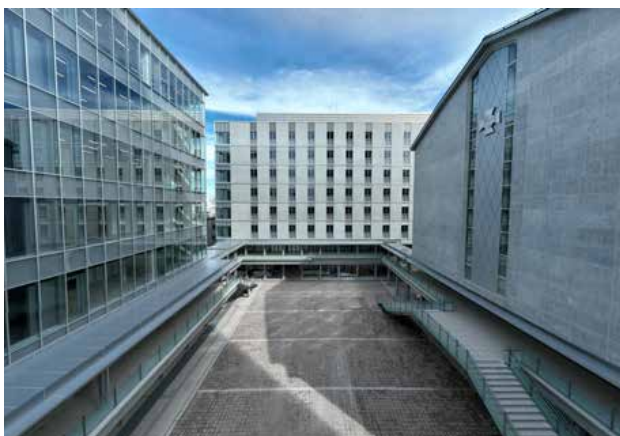
学生・建物をつなぐ回遊路「TGUリング」
