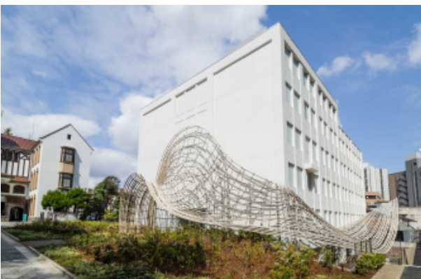
[写真] 内部を暗示するファサード
