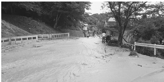
正門周辺学内道路の状況
