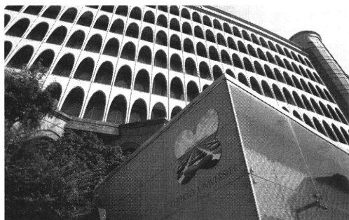
大学前の地下鉄換気棟の壁 (八事の蝶々をモチーフにデザイン)
