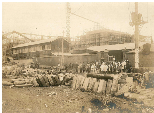
駿河台仮校舎と建設中の新校舎（1925年6月）
